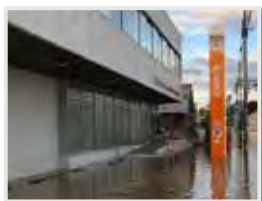
角田郵便局(宮城県)被害状況
