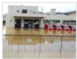
丸森郵便局(宮城県)被害状況
